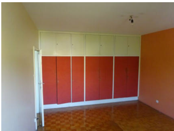
Raum über WZ begehbar
